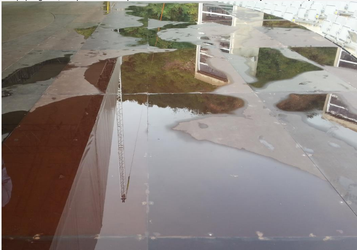
2.kép: pangó víz, melynek oka a helytelen szerelésből eredően a felület lejtésének hiánya
