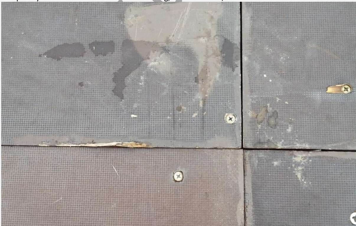
3.kép: helytelen szerelés: nincs dilatációs hézag, sérült lemezél, sérült felület
